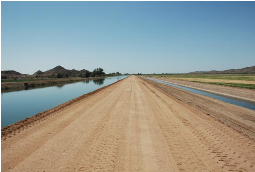
Fig. 2 Canal de suministro de agua (I) y canal de drenaje (D), distrito de riego y drenaje Wellton-Mohawk, Wellton, Arizona.
